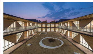
2. 陽光台小学校新築工事
