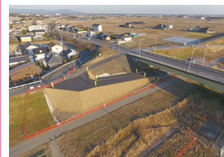
2. 鎌庭・伊讃管内周辺整備工事
