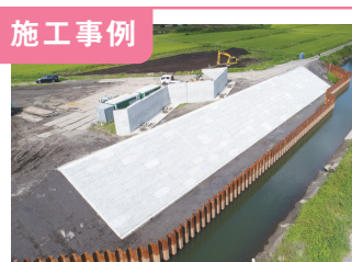
1. 堤防などを補強する護岸工事
