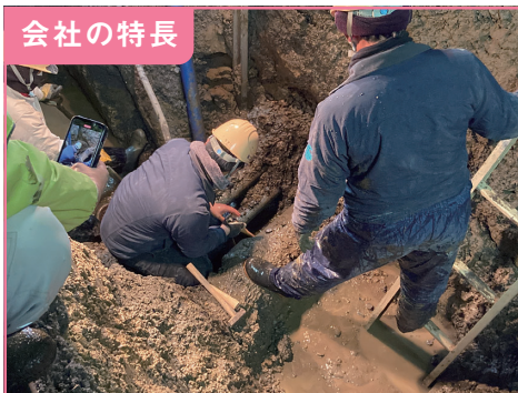
1. 緊急漏水修繕工事の様子
