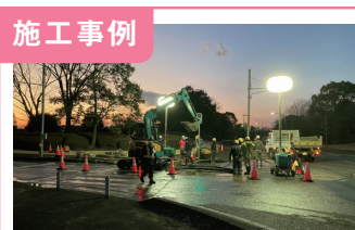
1. 緊急漏水修繕工事の様子
