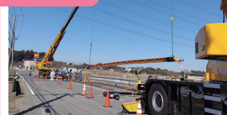
1. 上河原崎地区配水管布設工事
