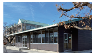
2. 柳橋小学校児童クラブ室新築工事
