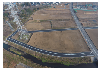
2. 宅地造成工事
