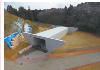
2. 東関東四鹿地区函渠工事
