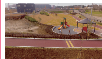
2. 阿見町吉原地区公園整備
