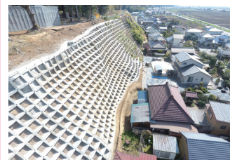
2. 急傾斜地崩壊対策工事
