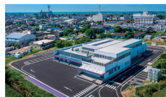
2. 建築工事施工事例
