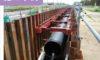
1. 鹿島工業用水道事業 配水管布設（耐震化）工事
