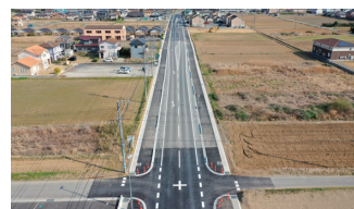
2. 都市計画道路改良工事
