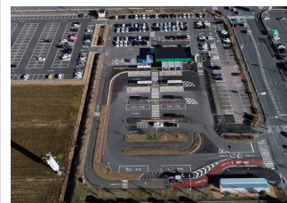
2. バスターミナル再整備工事
