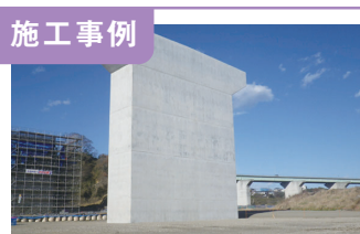
1. 新設道路の橋梁下部工事
