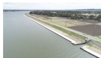
2. 河川の護岸災害復旧工事
