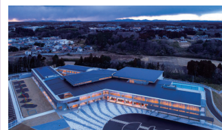
2. 銚田市立銚田南小学校新築工事
