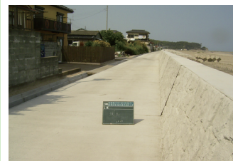
2. 津波を防いだ海岸の堤防嵩上工事
