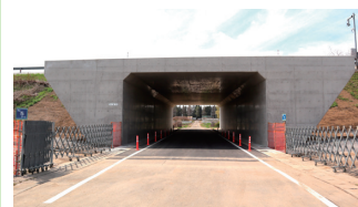
2. 圏央道つくば地区改良(ボックスカルバート)
