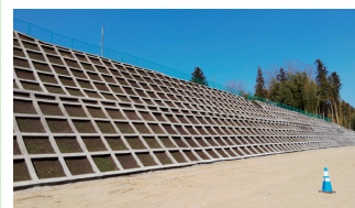
2. 道路改良工事
