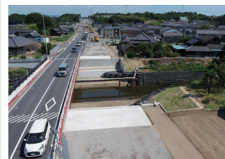
2. 国道245号新川橋二期
