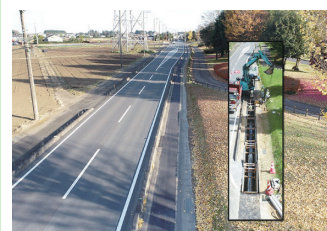
2. 工業用水道事業配水管布設工事
