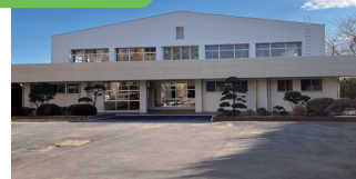
1. 那珂市菅谷西小学校体育館改修
