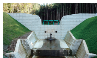
2. 砂防堰堤工事
