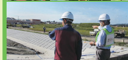
施工現場で安全パトロール中。社内でICTの最新技術の勉強会も行います。
