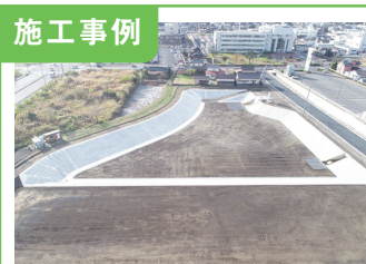
1. 大規模造成地の調整池整備工事
