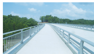
2. 長尾橋 橋梁付属物設置工事
