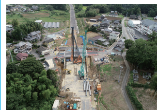
2. 県道空港アクセス線道路建設工事
