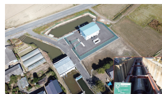
2. 東大場・島地区送水管その2工事
