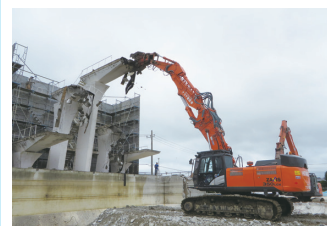
2. プールの解体工事
