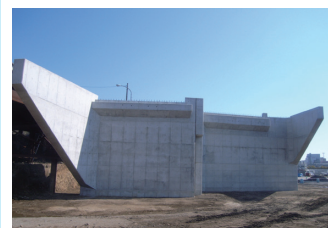
2. 水戸駅平須線橋梁下部工事
