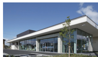
2. 結城信用金庫小山城南支店新築
