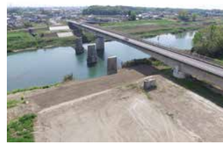
2. 鬼怒川橋 橋梁上部工撤去工事
