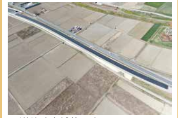
2. 道路改良舗装工事
