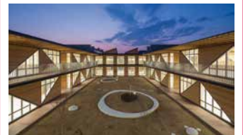
2. 陽光台小学校新築工事
