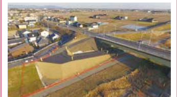
2. 鎌庭・伊譚管内周辺整備工事
