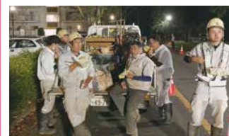
2. 緊急工事(恒例のハンバーガー休憩)
