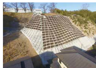
2. 急傾斜地崩壊対策工事
