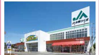
2. 建築工事施工事例
