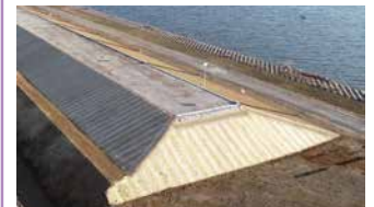
2. 利根川左岸仲新田堤防
