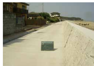
2. 津波を防いだ海岸の堤防嵩上工事
