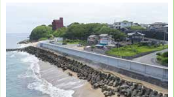
2. 水木海岸保全施設整備工事その4
