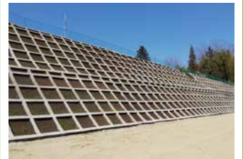
2. 道路改良工事
