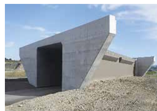
2. 国道118号道路改良工事
