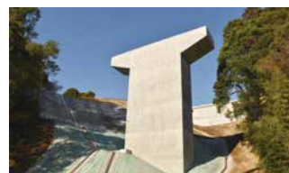
2. 常陸太田市増井町 第3号橋下部
