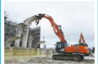
2. プールの解体工事
