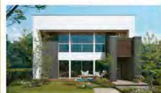
2. ミサワホームの木造住宅
