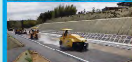
上段: 大洗友部線道路改良工事 下段: 茨城空港アクセス道路舗装工事
