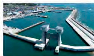
2. 茨城港大洗港区高潮対策水門工事
