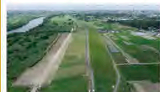
2. 渡良瀬川での堤防工事の完成写真
