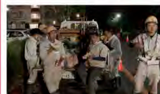
2. 恒例のハンバーガー休憩(緊急工事)
