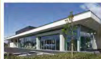
2. 結城信用金庫小山城南支店新築
