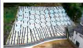
2. 急傾斜地崩壊対策工事(茨城県潮来土木事務所)
