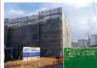
2. 建築工事: 県営住宅長寿命化工事
