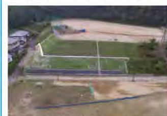
2. 稻田中学校 災害復旧工事
