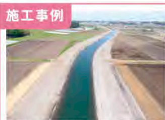
1. 地盤改良・河道掘削工事
