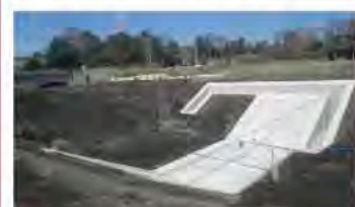
2. 飯田堰下部工事
