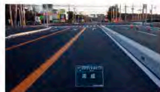
2. 交差点改良舗装工事
