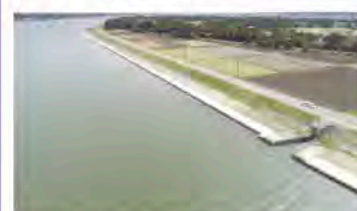
2. 河川の護岸災害復旧工事
