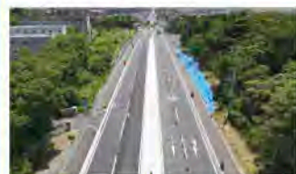
2. 国道245号道路改良工事
