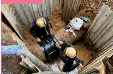
1. 緊急漏水修繕工事の様子
