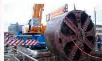
2. 雨水貯留施設工事
