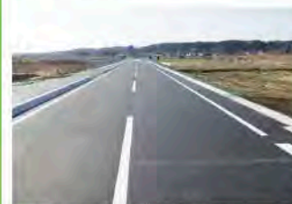
2. 静常陸大宮線道路舗装工事
