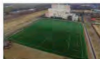
2. 公園自由広場改修工事(サッカー場)
