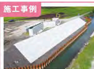
1. 堤防などを補強する護岸工事
