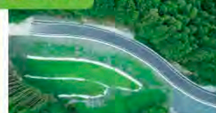
1. ICT施工で法面を整形した道路改良工事
