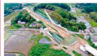
2. R5東関道北高岡地区改良工事
