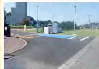
2. つくば西事業所北門外構整備工事
