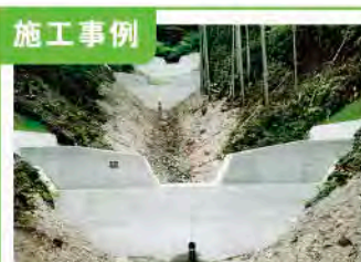
1. 砂防堰堤工事
