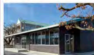
2. 柳橋小学校児童クラブ室新築工事
