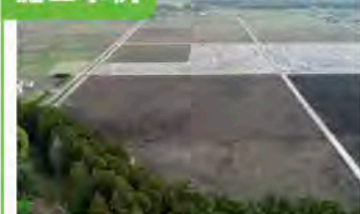
1. 農地整地工事(瓜連地区)
