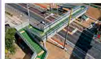
2. 鹿嶋市荒井地区 横断歩道橋設置工事
