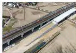
2. 下小目擁壁工事(つくばみらい市)
