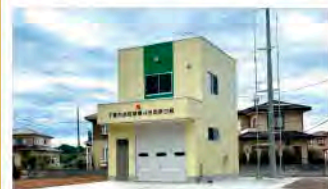
2. 下妻市消防団詰所 新築工事
