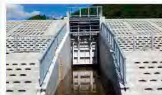
2. 砂防堰堤工事
