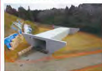
2. 東関道四鹿地区函渠工事
