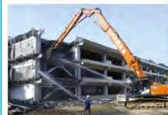
2. 某中学校の解体工事
