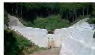
2. 田尻沢砂防堰堤工事
