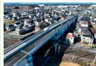
2. 高野橋橋梁修繕工事
