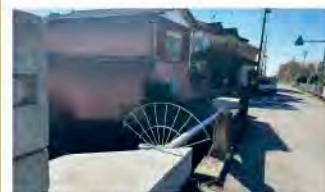
2. 水管橋布設替え工事
