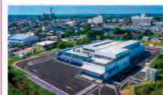
2. 建築工事施工事例
