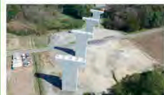
2. 常陸太田市瑞龍町 橋梁下部工事
