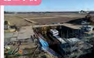
1. 土木工事: 用排水樋管工事
