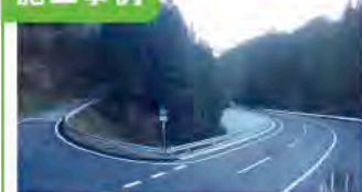
1. 31国補地道道路改舗装工事
