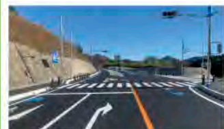
2. 道路改良工事
