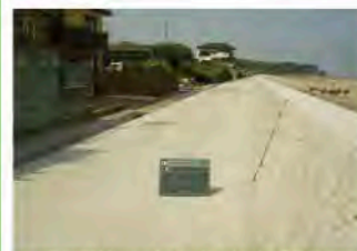
2. 津波を防いだ海岸の堤防嵩上工事
