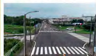
2. 野殿橋橋梁補修工事
