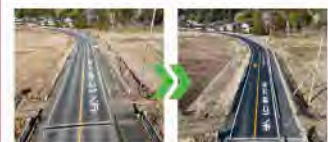
2. 牛久市久野町 舗装修繕工事
