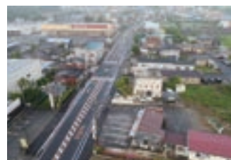
2. 交差点道路改良工事
