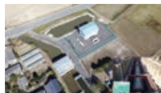
2. 東大場・島地区送水管その2工事
