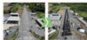
2. 牛久市女化町舗装修繕工事
