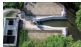
2. R3 霞ヶ浦導水桜機場周辺整備工事
