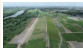
2. 渡良瀬川での堤防工事の完成写真
