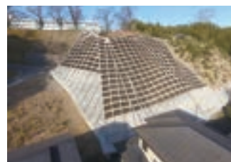
2. 急傾斜地崩壊対策工事
