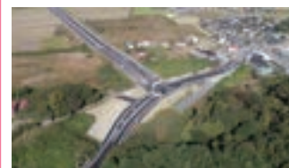
2. 国道125号改良舗装工事
