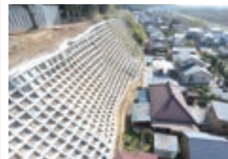
2. 急傾斜地崩壊対策工事
