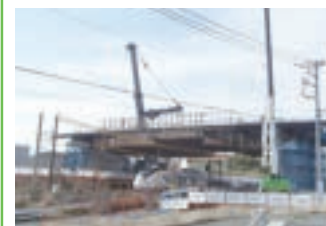
2. 橋梁架設工事
