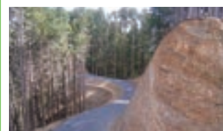
2. 関沢・舟生林道新設工事
