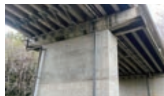
2. 橋梁安全対策工事
