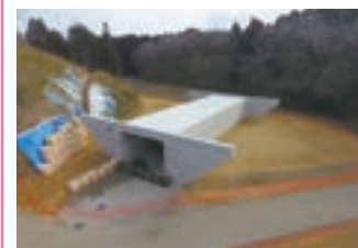
2. 東関東道四鹿地区函渠工事
