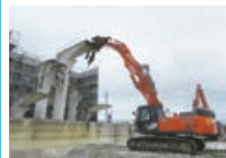
2. プールの解体工事
