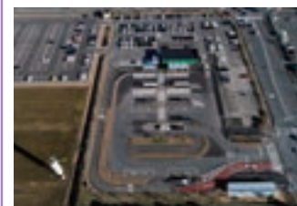
2. バスターミナル再整備工事
