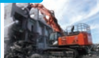
1. 鉄筋コンクリート造の建屋解体工事
