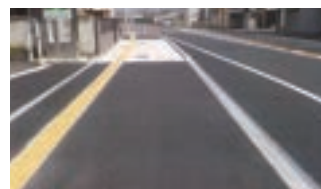
2. 道路改良舗装工事
