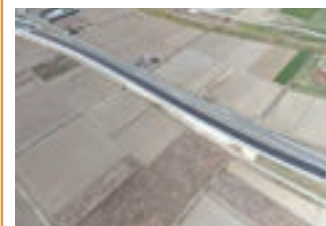
2. 道路改良舗装工事
