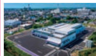
2. 建築工事施工事例
