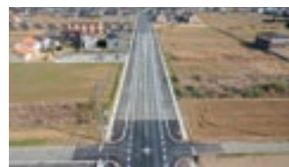
2. 都市計画道路改良工事
