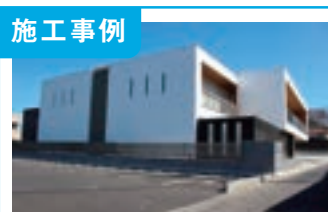
1. K 様邸新築工事
