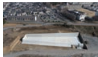
2. 中丸川調整池洪水吐施設
