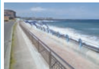
2. 海岸護岸改修(大洗町磯浜)
