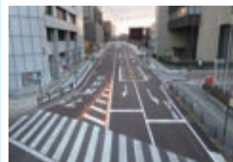
2. 三の丸道路舗装工事
