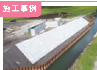
1. 堤防などを補強する護岸工事
