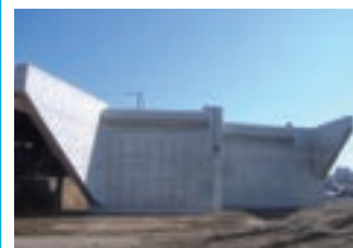
2. 水戸駅平須線橋梁下部工事
