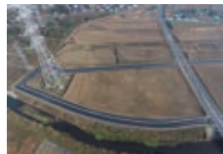
2. 宅地造成工事
