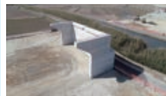
2. 潮来市東関道橋梁下部工事
