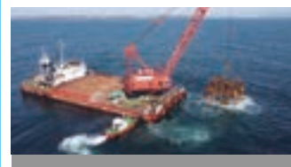
2. 那珂湊漁礁設置工事
