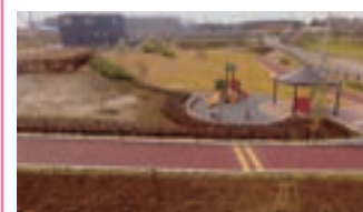
2. 阿見町吉原地区公園整備
