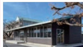
2. 柳橋小学校児童クラブ室新築工事
