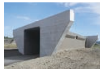
2. 国道118号道路改良工事
