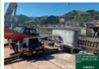
2. R3久慈川松沼橋下部工新設工事
