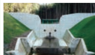
2. 砂防堰堤工事
