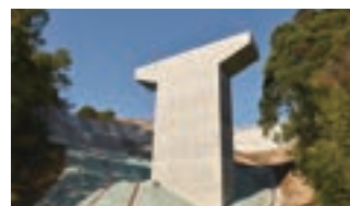
2. 常陸太田市増井町 第3号橋下部
