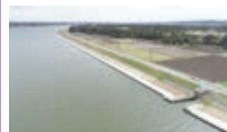
2. 河川の護岸災害復旧工事
