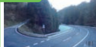
1. 31国補地道道路改舗装工事
