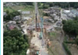
2. 県道空港アクセス線道路建設工事
