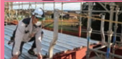
専門業者の方との打合せを重ねて施工精度を上げていきます
