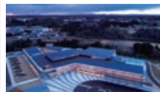
2. 鉾田市立鉾田南小学校新築工事
