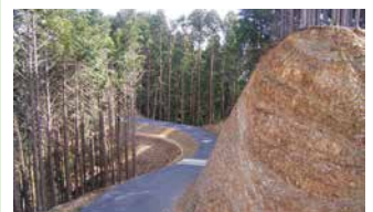
2. 関沢・舟生林道新設工事
