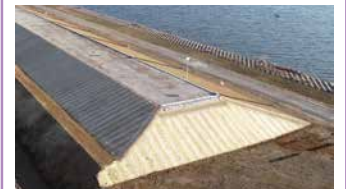
2. 利根川左岸仲新田堤防
