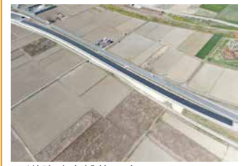
2. 道路改良舗装工事
