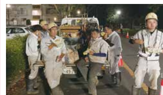
2. 緊急工事(恒例のハンバーガー休憩)
