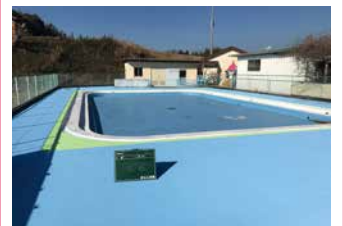
2. 美浦幼稚園プール修繕工事
