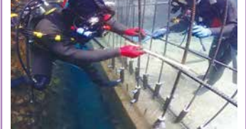
1. 水中での鉄筋組立の様子
