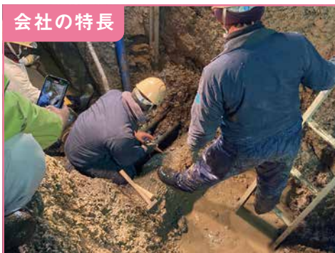
1. 緊急漏水修繕工事の様子
