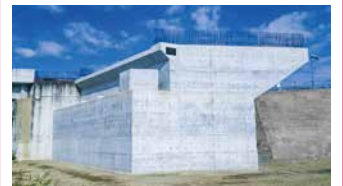
2. R2千代田石岡BP橋台下部工事
