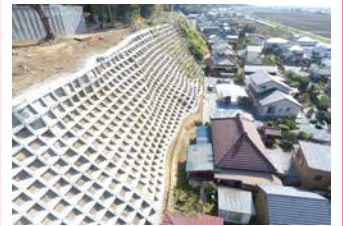
2. 急傾斜地崩壊対策工事
