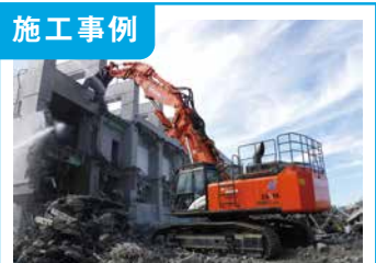
1. 鉄筋コンクリート造の建屋解体工事
