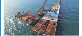
1. 常陸那珂港区外港地区東防波堤築造
