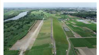
2. 渡良瀬川での堤防工事の完成写真
