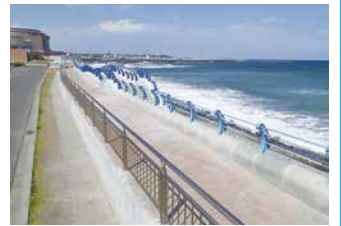
2. 海岸護岸改修(大洗町磯浜)
