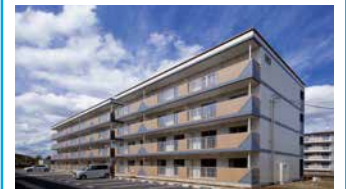
2. 桜川西アパート103・4号棟建設
