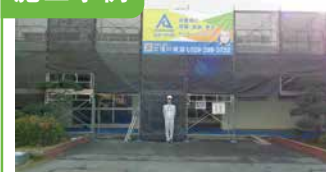
1. 那珂市菅谷西小学校体育館改修
