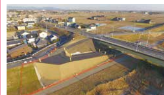
2. 鎌庭・伊譚管内周辺整備工事
