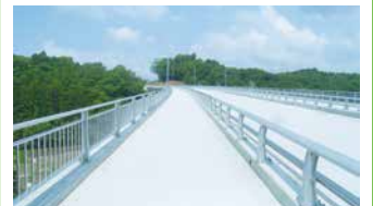
2. 長尾橋 橋梁付属物設置工事
