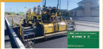
1. 筑西幹線道路ICT施工状況
