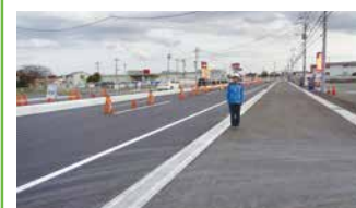
2. 国道118号(瓜連)道路舗装
