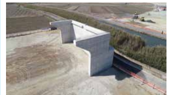
2. 潮来市東関道橋梁下部工事
