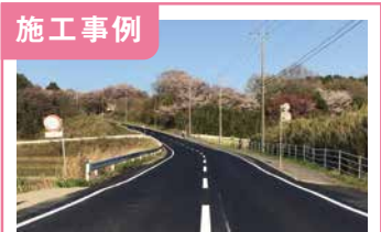
1. 境田地区道路舗装
