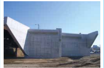
2. 水戸駅平須線橋梁下部工事
