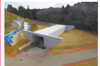
2. 東関東四鹿地区函渠工事
