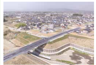
2. 勝木田下の内線「神楽沢橋」
