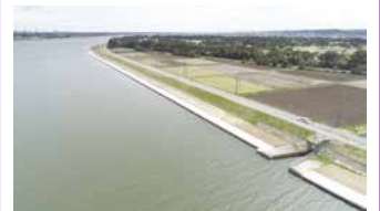
2. 河川の護岸災害復旧工事
