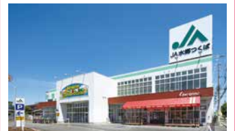
2. 建築工事施工事例
