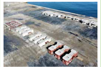
2. 直立消波ブロック製作工事
