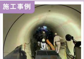
1. 内径3000mm推進工事 坑内
