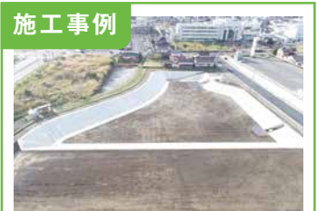
1. 大規模造成地の調整池整備工事
