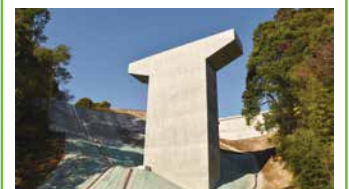
2. 常陸太田市増井町 第3号橋下部
