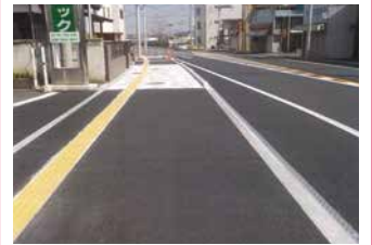
2. 道路改良舗装工事
