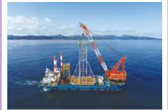
2. 海上伸縮式ボーリングタワー
