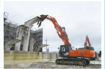
2. プールの解体工事
