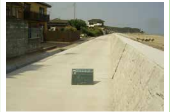
2. 津波を防いだ海岸の堤防嵩上工事
