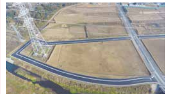
2. 宅地造成工事
