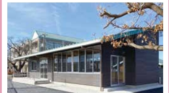
2. 柳橋小学校児童クラブ室新築工事
