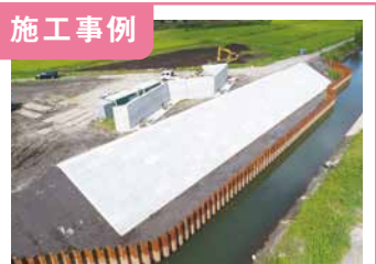
1. 堤防などを補強する護岸工事
